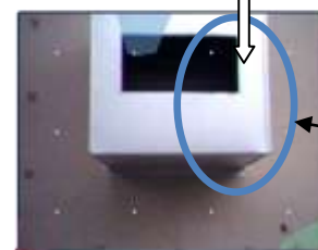
施工後のダクトの状態
